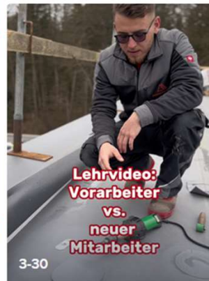
3-30 Lehrvideo: Vorarbeiter vs. neuer Mitarbeiter #asmr #roofer #lehrvideo #dachdecker ... proaktivdach ▷ 37.1K
