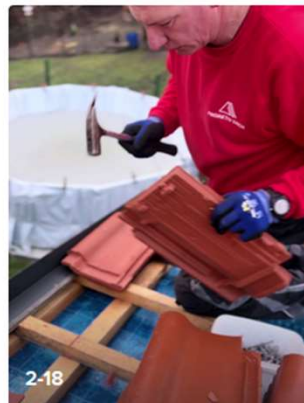
2-18 #roofersoftiktok #asmr #roofer #dachdecker #proaktivdach... proaktivdach ▷ 2.8M
