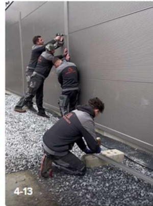
4-13 #roofer #funny #dachdecker #baustelle... proaktivdach ▷ 2.1M
